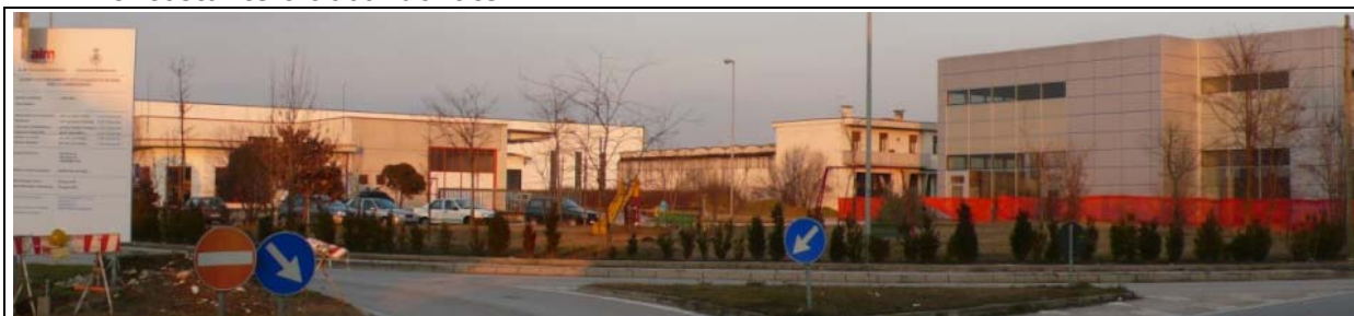
Zona industriale località San Benedetto al confine con Pozzoleone
