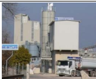
Attività lavorazione ghiaia
